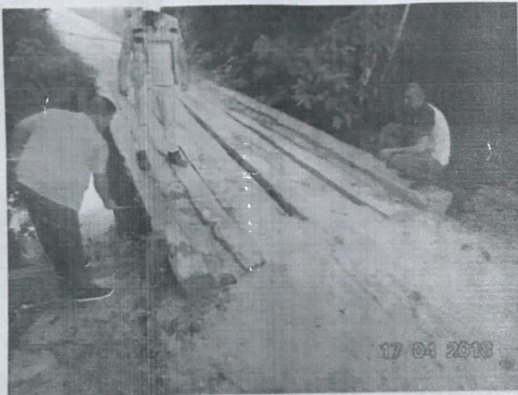
Ponte Pedra Branca GPS (S1°47'27.1" W55°11'57.5") – Foto 21
